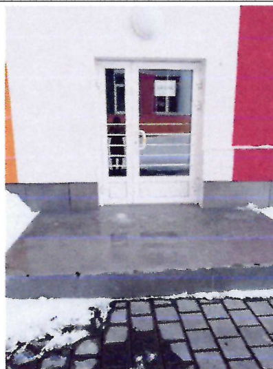
Фото № 46 площадка эвакуационного выхода
