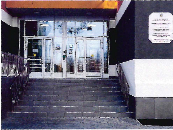
Фото №5—Вход в здание
