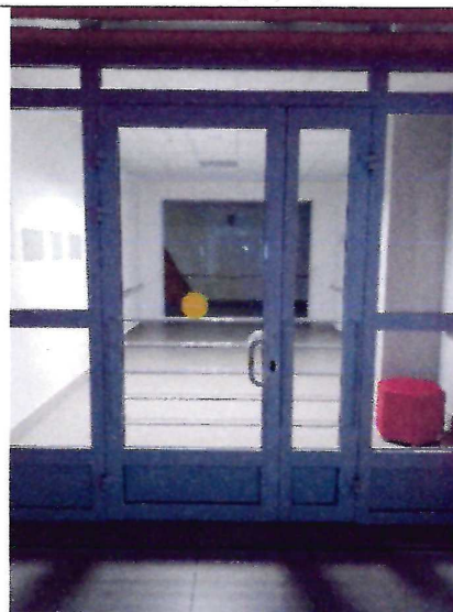
Фото № 22 переход между блоками
