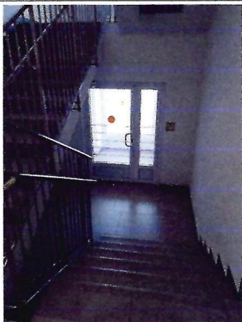
Фото № 43 лестница эвакуационного выхода
