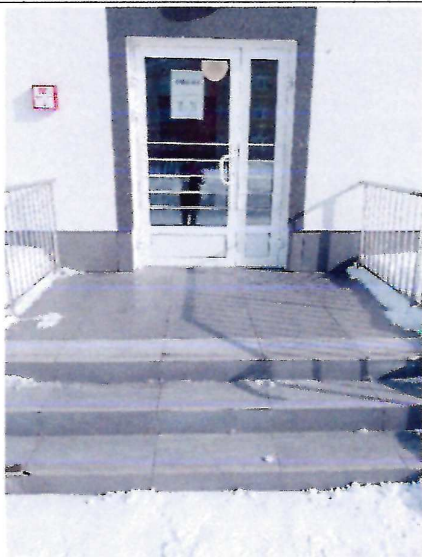
ОФото № 45 площадка эвакуационного выхода
